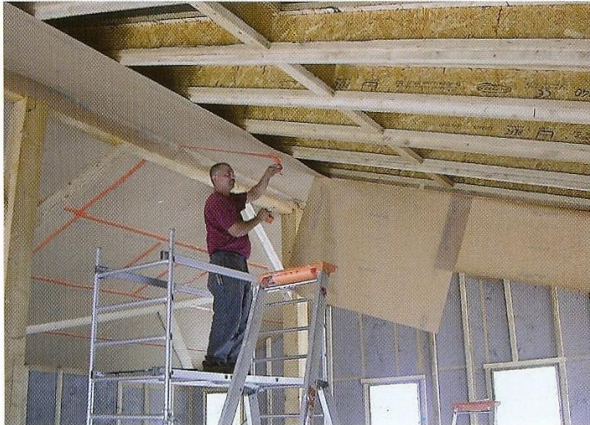
Au plafond, une toile papier armée de fibres naturelles est agrafée aux poutres formant ainsi des caissons dans lesquels sera insufflée la ouate de cellulose. L'épaisseur de l'isolant est de 28 cm. En finition un panneau Fermacell est marouflé.
