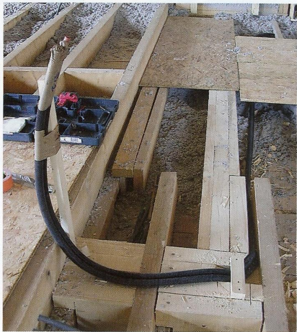
Le solivage est rempli de ouate de cellulose.
